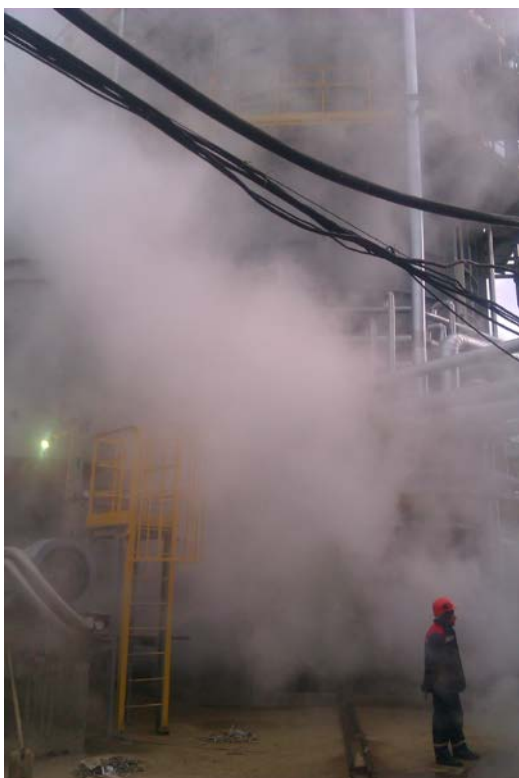
Рис.2. Рабочая «высота» срабатывания паровой завесы при защите печи от взрывоопасного облака.
